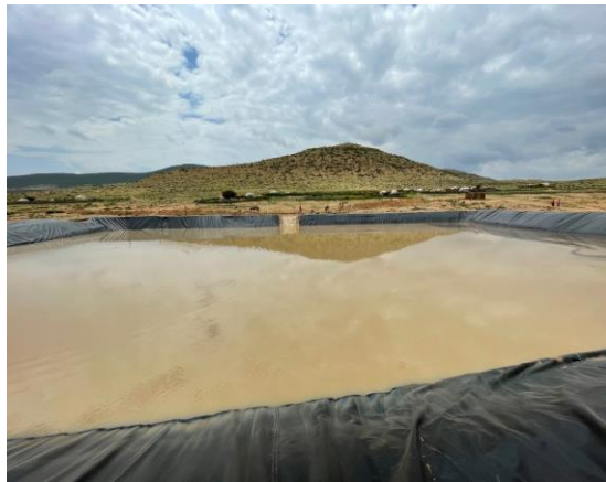
完成した貯水池
