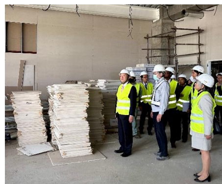
同センター建設現場視察
