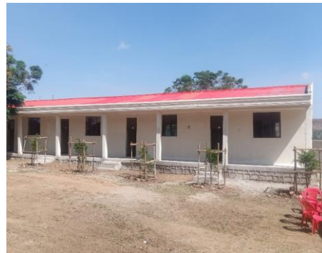
新しい職業訓練施設外観
